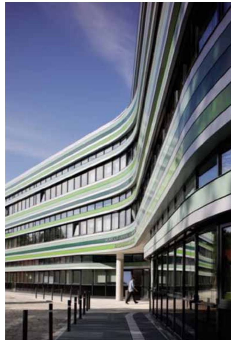
Haupteingang des Laborgebäudes
