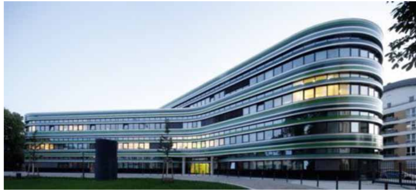
Blick vom Innenhof auf das Laborgebäude
