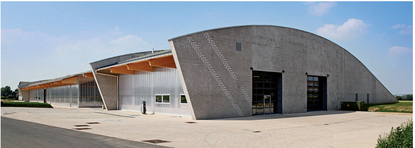
Bild 4. Kräftige Wandscheiben begrenzen die aufgeschütteten Erdwälle der Werkstatt- und Maschinenhalle
