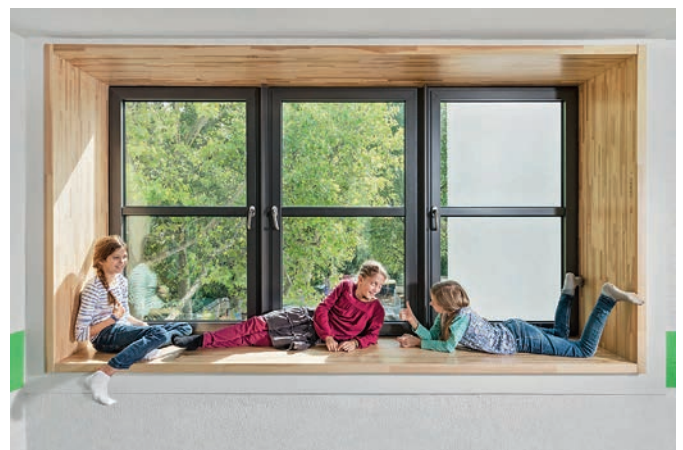
Bild 7. Die 3-fach verglasten Fenster
