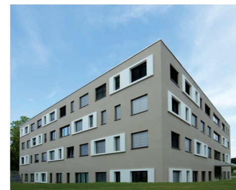
Blick von Südwesten
