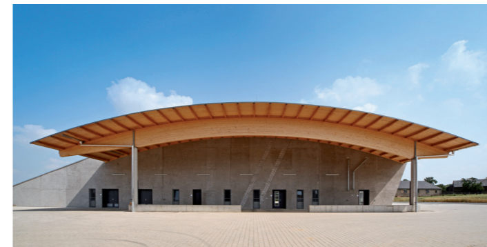
Purismus: Holz und Beton
