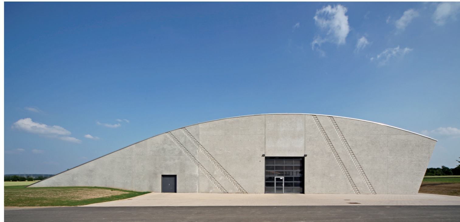
Wellenbegleitende Betonwände mit Traktorspuren
