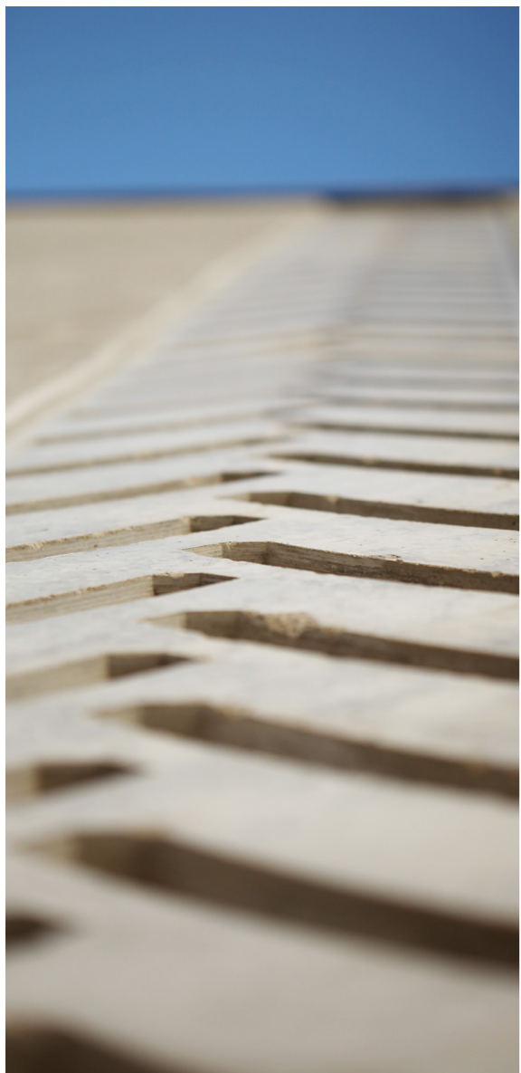
Traktorspuren eingelassen in der Außenwand
