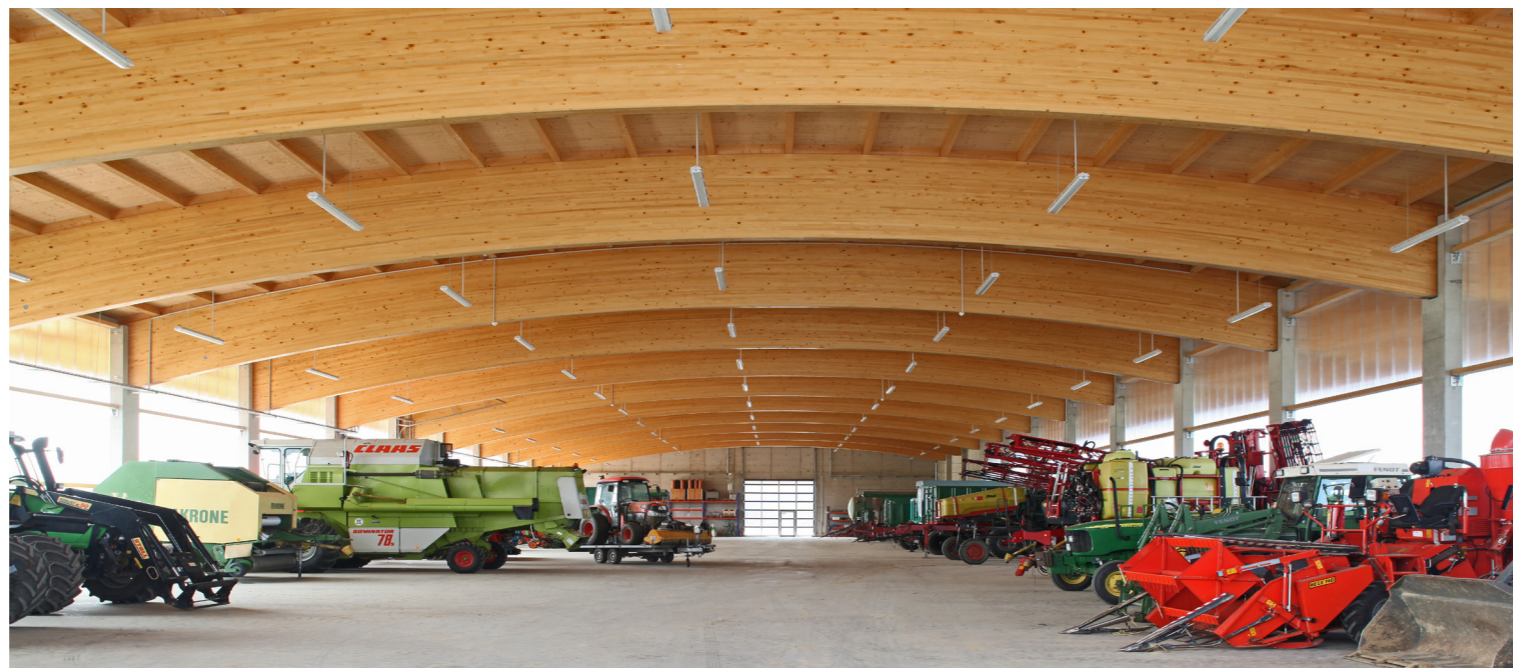
Die Dachkonstruktion basiert auf einer Holzleimkonstruktion mit einer Spannweite von 25 m
