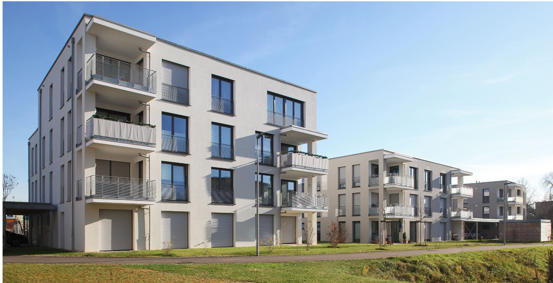
Blick von Nordwesten auf Bauabschnitt 2 und 3
