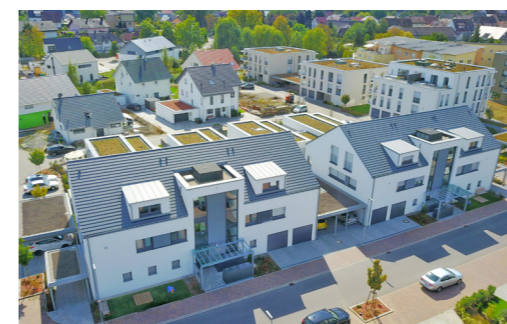
Bauabschnitt 4 mit Blick auf Bauabschnitt 2 und 3
