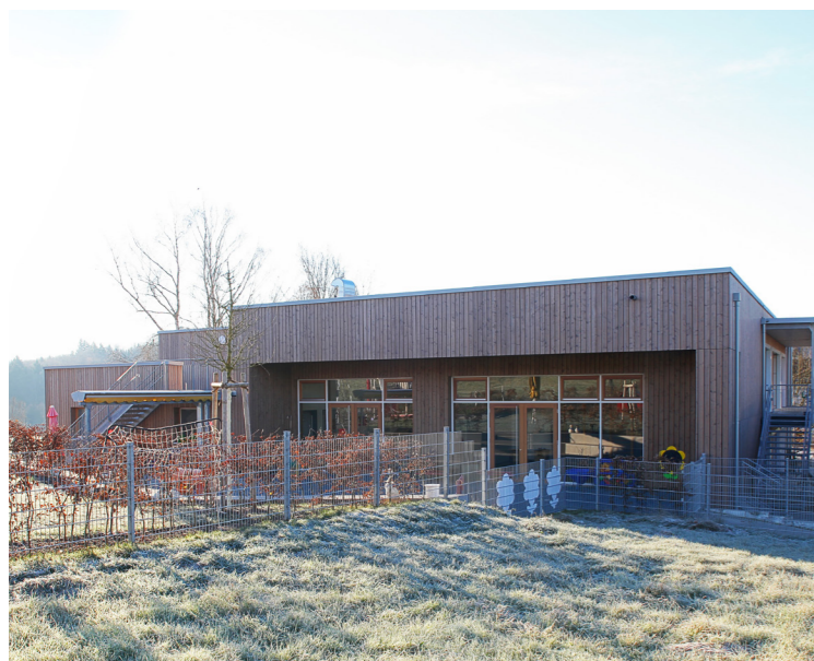
Blick von den Obstbaumwiesen auf die Nordfassade
