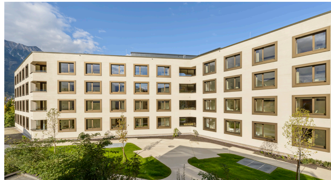
Die Südwestfassade mit dem vorgelagerten Demenzgarten
