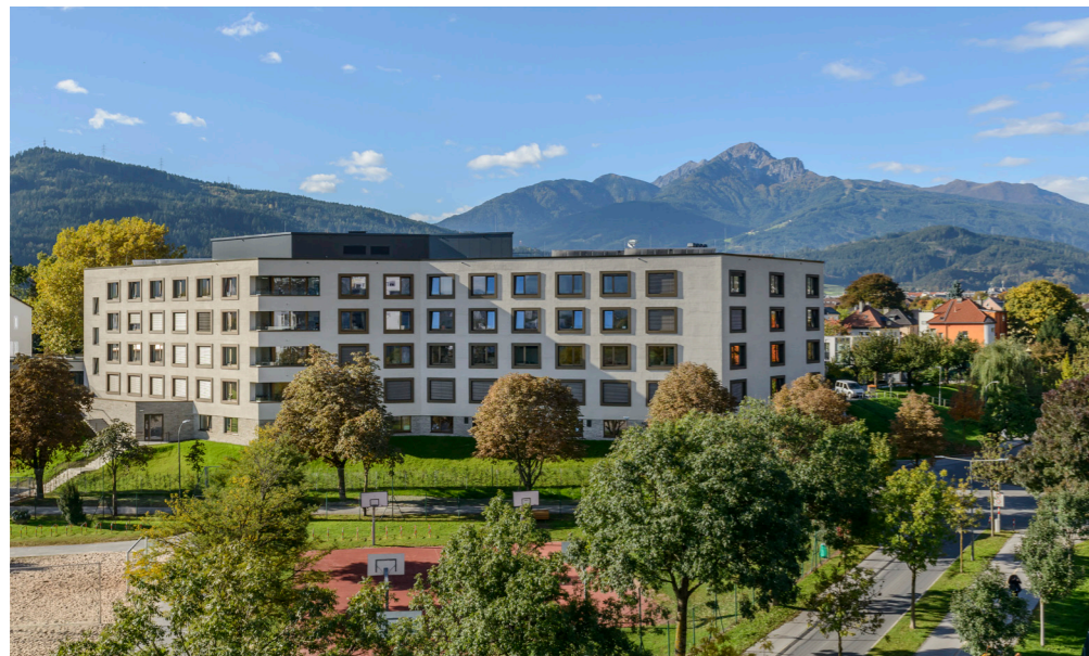
Blick von Norden auf das neue Pflegeheim
