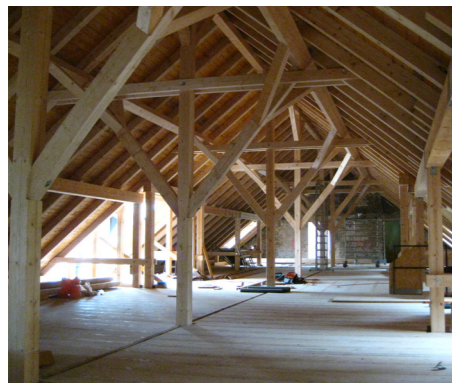
Neubau des Dachgebälks
