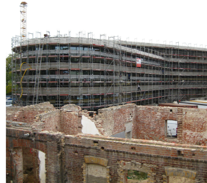
Abbruch bis auf die Grundmauern - im Hintergrund die Rohbauarbeiten des Neubaus
