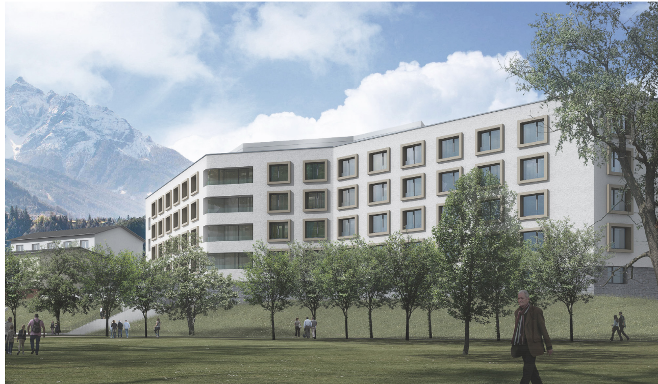
Blick zum Haupteingang
