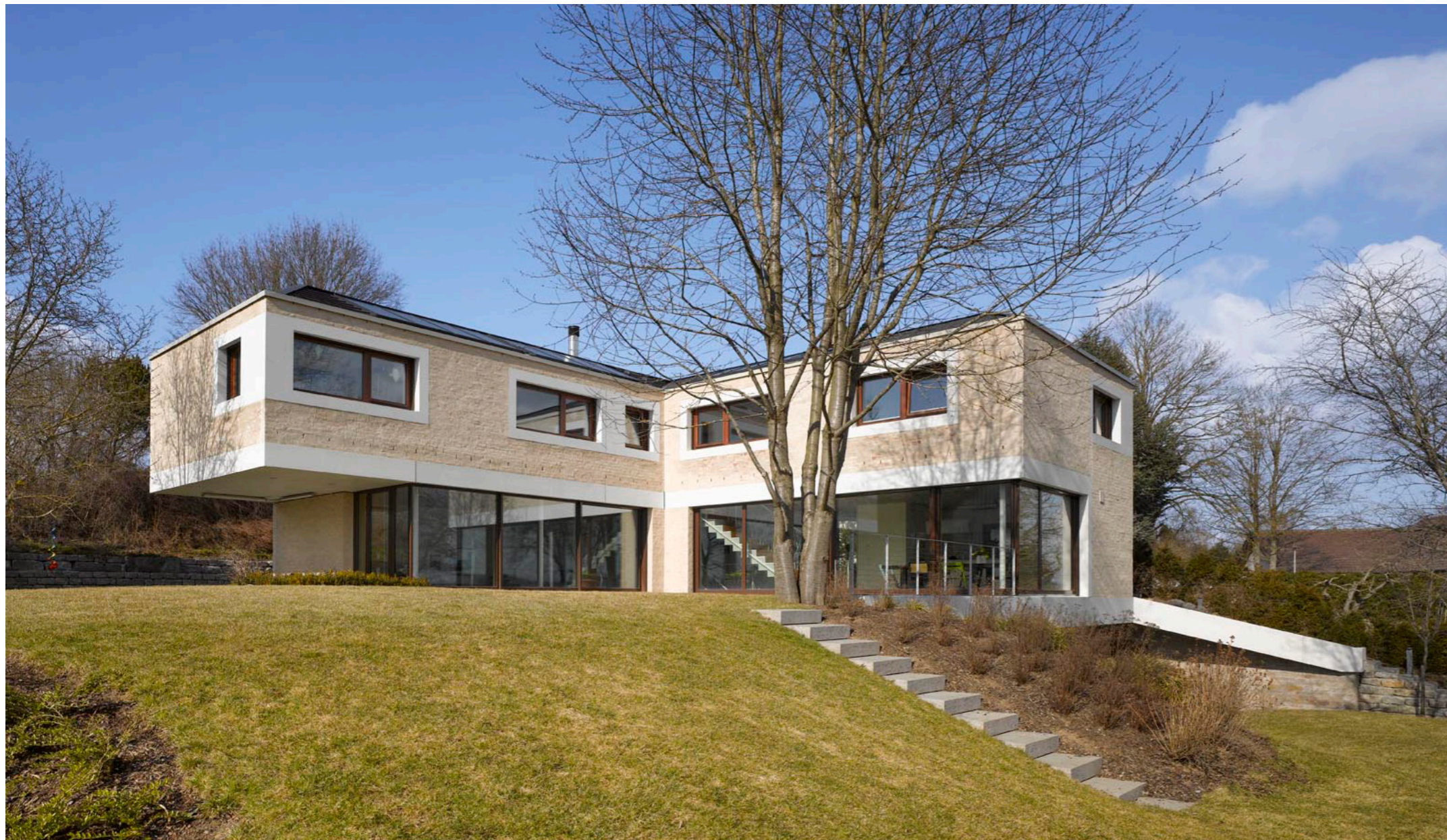
Blick von Südwesten
